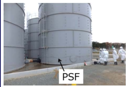
1F汚染水タンクの漏洩検知試験
